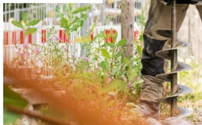
Zum Sichern der Baustelle werden Löcher für die Bauzäune gebohrt.
