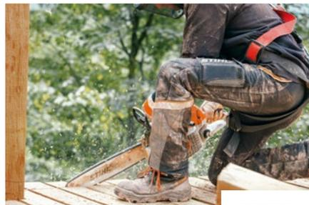
Sind alle Bodenbalken verlegt, wird der Rand mit der Säge „glattgezogen“.
